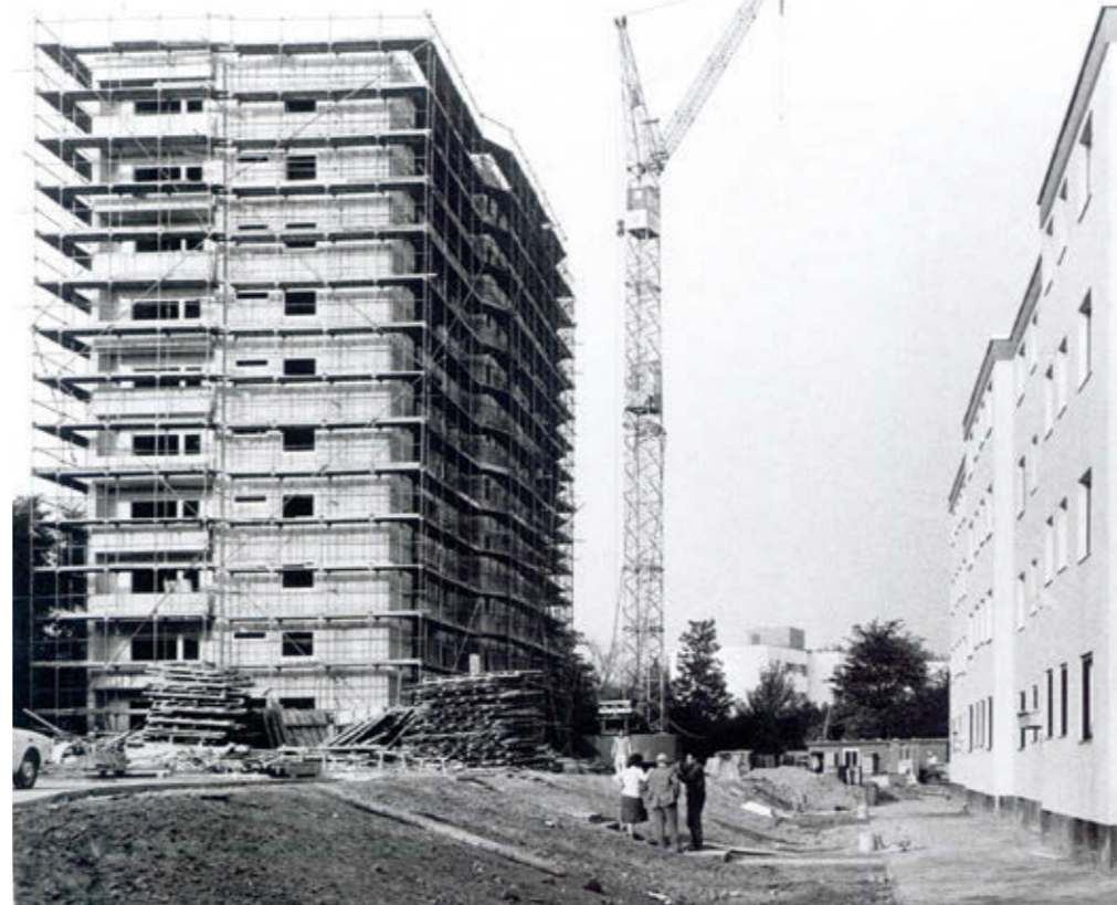
Die Charlottenstraße in Bau, 1968
