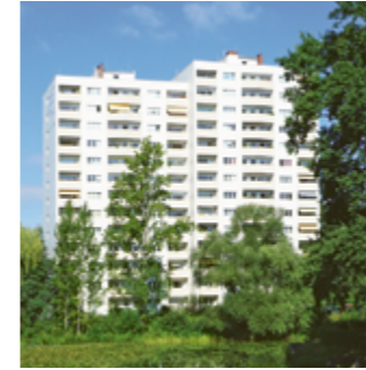
Sanierung der Aufzüge > Seite 11
