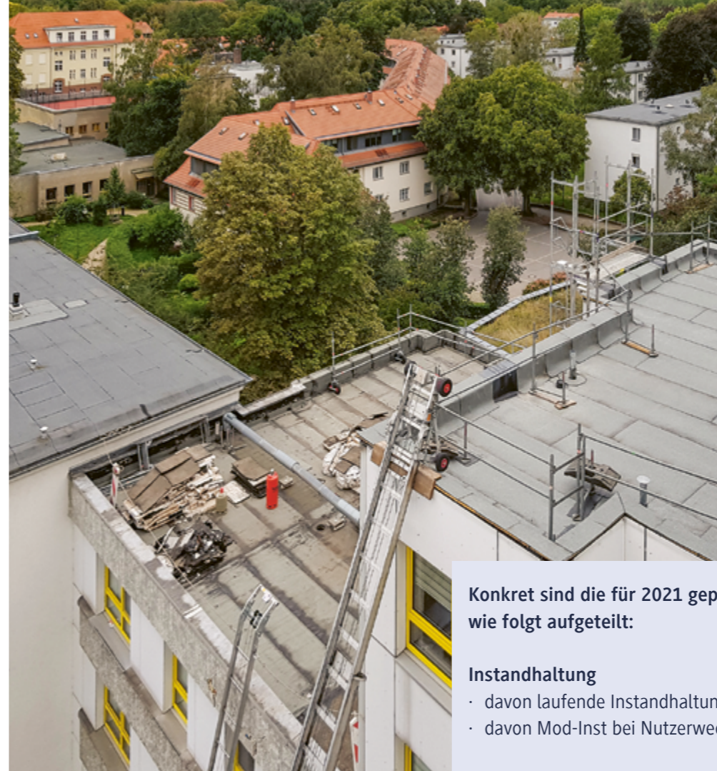
Sanierung der Flachdächer des Brückenhauses Eythstraße 43 und Domnauer Straße 1A
