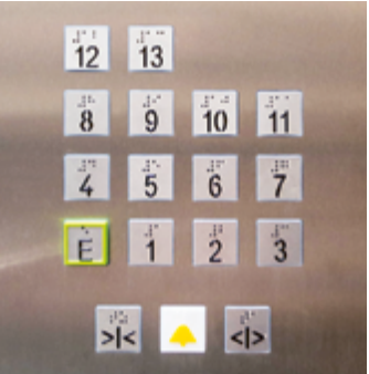
Sanierung der Aufzüge > Seite 4
