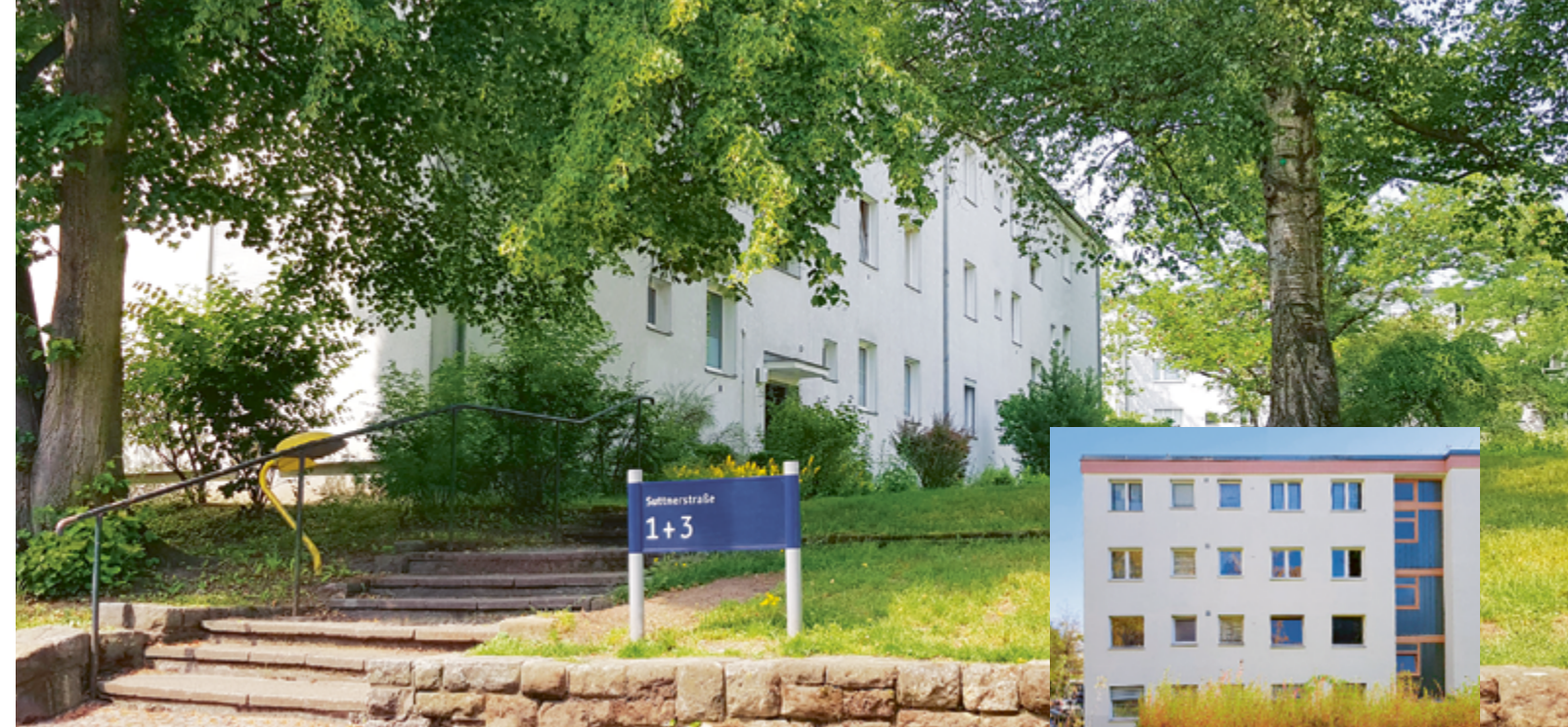
Sanierter Zeilenbau Suttnerstraße 1 und 3
