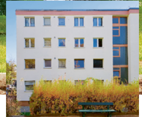
Wohnanlage Charlottenstraße mit neu eingebauten Fenstern
