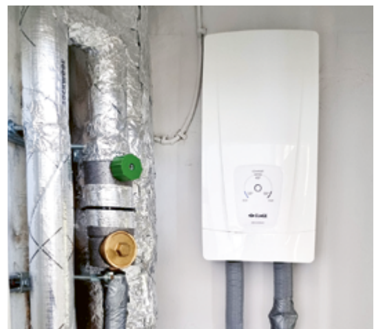
Warmwasserbereitung mit umweltfreundlichem Durchlauferhitzer
