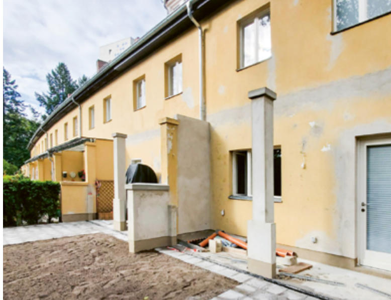
Wärmedämmung im Lindenhof I
