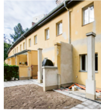
GeWoSüd dämmt Fassaden > Seite 9
